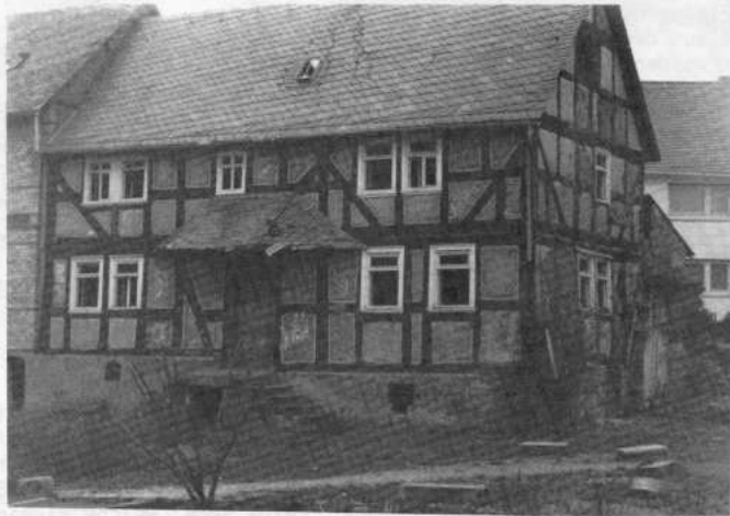
Wohnhaus Ruppert (Marburger Str.) vor dem Abbruch
